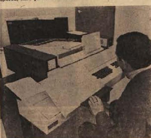
V NOVOTEKSU so prvi na Dolenskem nabavili elektronski računalnik PHILIPS SIEMAG — DATA — 16 K. Namen tega računalnika, ki je stal 600.000 dinarjev, ni samo da nadomešča delovno silo v evidenčnih službah in druge, ampak da hitro preračuna ustrezne pokazovalce, s katerimi se lahko prilagaja proizvodnja tržnim razmeram. Razen tega veliko pomaga pri usklajevanju proizvodnih faz. Odlikujeta ga neprekosljiva natančnost in hitrost opravljanja računskih operacij. (Foto: S. Dokl)
