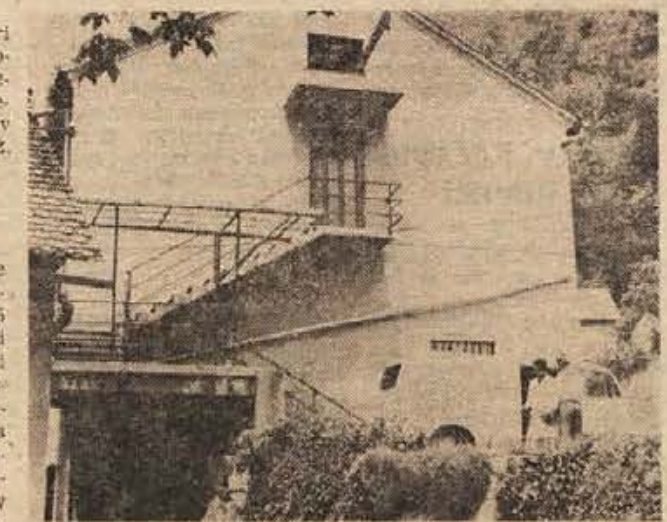
IMPERIAL je tako potisnjen v hrib, da v taki stiski ne more več dolgo ostati. Obrat za izdelovanje žvečilnega gumija bodo preselili v Staro vas, kjer nameravajo graditi novo tovarno. (Foto: J. Teppy)
