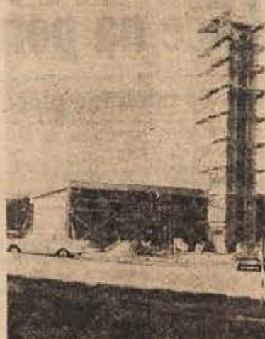
Gradnja novega gasilskega doma v Metliki spomladi 1969
