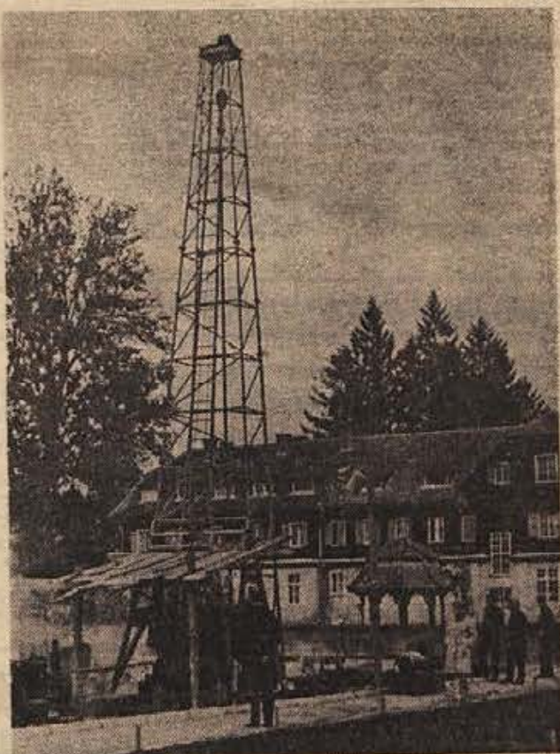
Strokovnjaki Geološkega zavoda iz Ljubljane, ki opravljajo hidrološko raziskovalno vrtanje v Cateških Toplicah, so že v prvi izvrtini našli na močan izvir termalne vode. Iz globine 305 do 326 metrov priteče vsako minuto okoli 2000 litrov vode, tople 62 stopinj C. Tak izvir je pri nas izredno redek in bo kril vse potrebe Cateških Toplic, ki postajajo največji turistični center na Dolenjskem. (Foto: M. Vesel)
