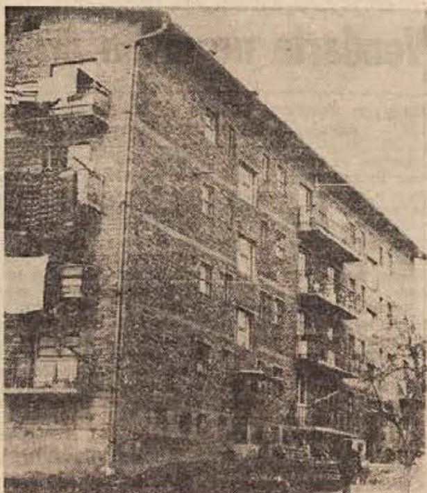
Najslabše postore ima krška osnovna šola v samskem bloku na Vidmu. Stavba je stara deset let, še vedno ni ometana, razen tega pa za učilnice sploh ni primerne, saj pozimi v njih vleče, četudi so vrata zaprta. Učencem manjka zraka, ker so prostori zelo nizki. Tudi ni prave svetlobe. (Foto: Jožica Teppey)
