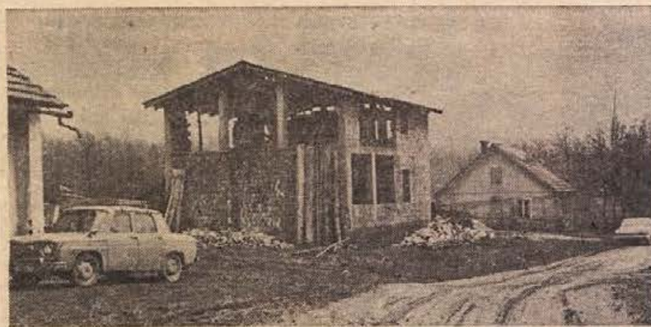
Kmalu bo leto dni, kar so se vaščani Rožnega doła in okoljskih vasi odločili sami graditi novo osnovno šolo, ker je stara tako dotrajana, da so otroci v njej že v nevarnosti. Z udarniškim delom so novo šolo že spravili pod streho.
