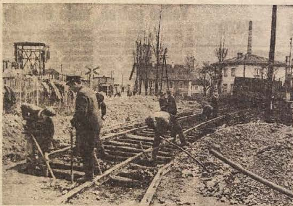
V priprave na proslavo stoletnice sevniskega tabora šteje tudi asfaltiranje nekaterih ulic v Sevnici. Prejšnji teden so pri Jugotanimu začeli z delom. (Foto: Legan)
