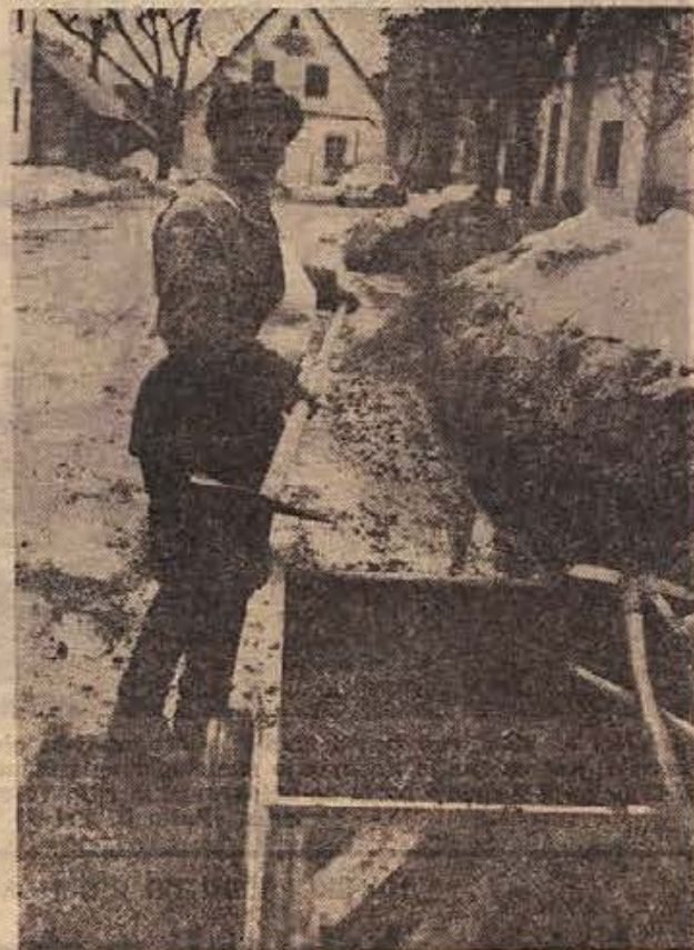
Cesta med Zlebičem in Prigorico je popolnoma uničena. Med cestarji, ki jo marljivo vzdržujejo, je tudi Jože Debeljak, ki meni, da je imel ta del ceste pre-slabo podlago za asfalt. Zaradi velikih lukenj in popolnoma uničenega cestnišča je tudi vožnja omejena na 30 km na uro (Foto: Prime)
