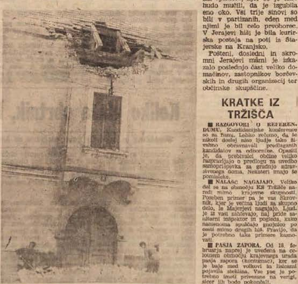
PA RAVNO OBČINSKA HIŠA. 21. februarja ponoči je z občinske hiše v Sevnici zdrsnil sneg in pri tem odnesel del strehe nad balkonom ter poškodoval električno razsvetljavo. (Foto: F. Pavkovič)
