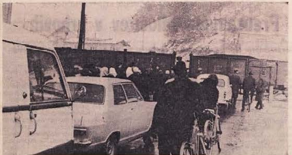
Predvideno je, da bo še letos elektrificirana železniška proga do Dobove. Pri Boštanju že gradijo veliko transformatorsko postajo, vprašanje pa je, kaj bo z železniškimi prehodi, ki ovirajo cestni promet. V Sevnici se včasih naberejo še daljše kolone na obeh straneh železniške proge. (Foto: Legan)
