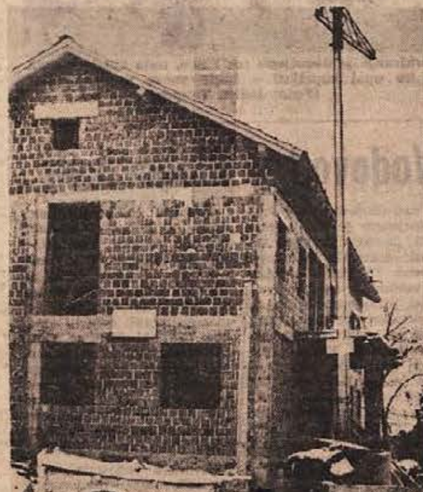
Cez zimo so se nehala dela pri gradnji nove stavbe Doma počitka. Stavba je pod streho, spomladi pa bodo gradili dalje. Računajo, da bodo že na jesen lahko sprejeli ostarele v lepo urejene sobe novega doma. (Foto: R. Bačer)
