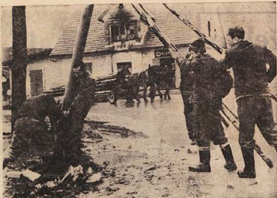
DO 25. NOVEMBRA V STRAZI JAVNA RAZSVETLJAVNA - V sredo dopoldne so delavci ELEKTRA Novo mesto postavljali v Straži drogeve za javno razsvetljava za 10 živosrebrnih svetilk. Dela bodo stala blizu 60.000 din, zbrala pa jih je krajevna skupnost Straža. Kot zanimivost naj omenimo še, da je pripravljala dela opravila krajevna skupnost v lastni režiji. Pravijo, da gre tako bolj poceni. (Foto: S. Dokl)
