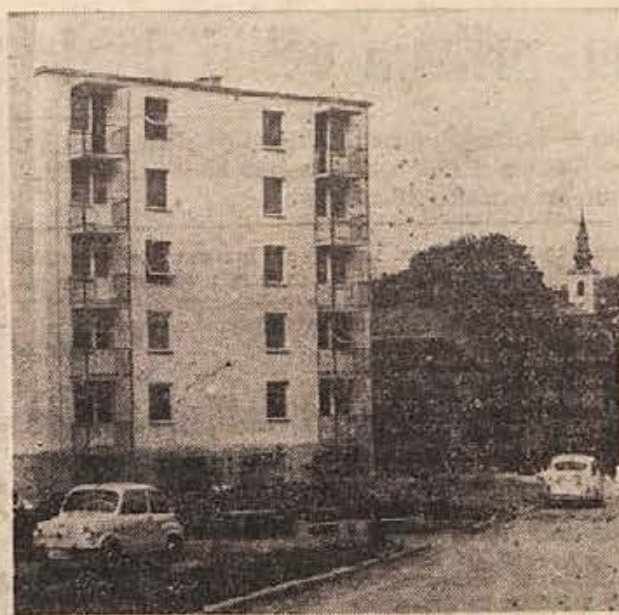
20-stanovanjski blok s centralno kurjavo, ki ga v Metliki gradi podjetje PIONIR iz Novega mesta za trg, bo v kratkem vseljiv. Konec meseca je napovedan tehnični prevzem. (Foto: Ria Bačar)
