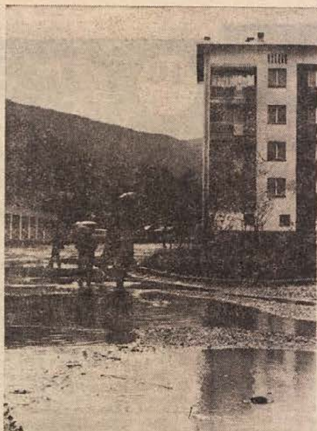
Cez take luže se zadnje deževne dni prebijajo stanovalci četrtega in petega bloka v Podgorski ulici v Kočevju. Upajo pa že celo leto, da bo kdo vendarle dokončno uredil kanalizacijo in pripeljal kak kamion peska, da bodo izginile luže s ceste okoli blokov. (Foto: Brus)
