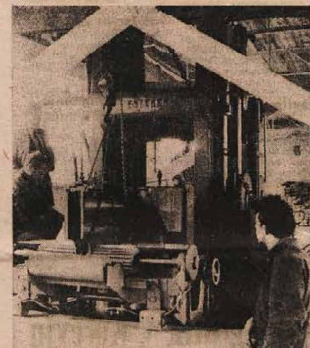
Stroje v novi žagi LİK so pred kratkim že postavili, medtem ko jih bodo v novi tovarni ivernih plošč začeli montirati te dni
