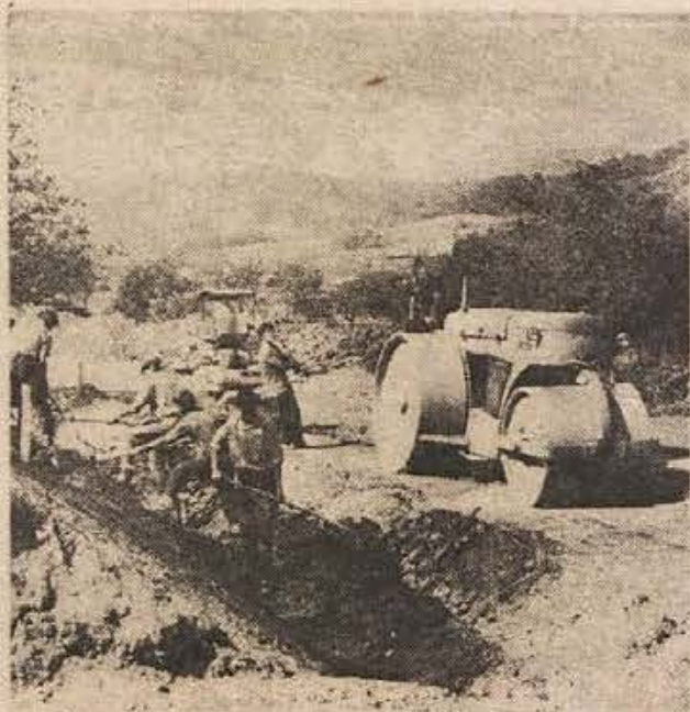
Na Kompoljskem polju nastaja cestišče za novi del asfaltna ceste Sevnica-Radeče. V pogodbi z gradbenim podjetjem Gradis je zapisano, da bo celotna trasa modernizirana do 1. junija prihodnje leto. (Foto: Legan)
