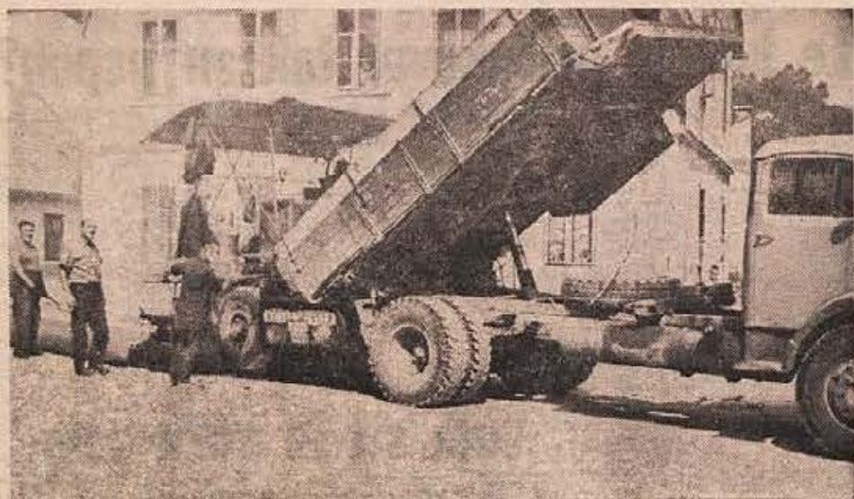
Krčanom se je izpolnila davna želja. Prašni Hočevarjev trg prelivajo z asfaltom. Asfaltirali bodo tudi cesto, ki pelje od tam za mestom tik pod hribom. (Foto: J. Teppey)
