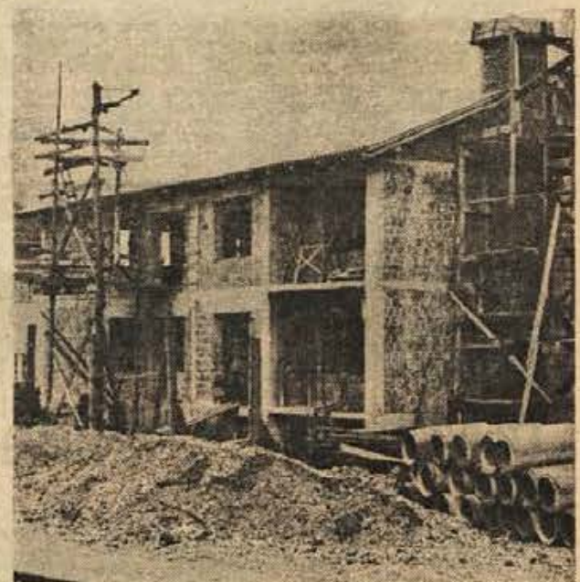
Poleg Mercatorjeve samopostreznice v Metliki že stoji nova postaja milice. Gradnja, ki jo je prevzelo gradbeno podjetje Črnomelj, bo končana prihodnji mesec (Foto: Ria Bačar)
