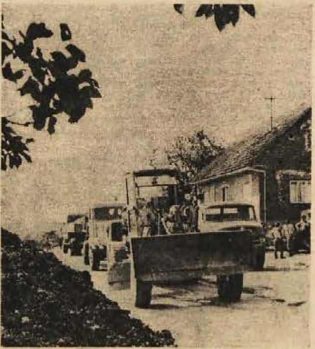
Asfaltni trak se je podaljšal na cesti Črnomelj-Vinica že do Stare Lipe, s težkimi buldožerji pa utrjujejo tudi še zadnje kilometre ceste proti Vinici. Če vreme v septembru ne bo prehudo nagajalo, bodo dela na cesti končana v predvidenem roku (Rb.)
