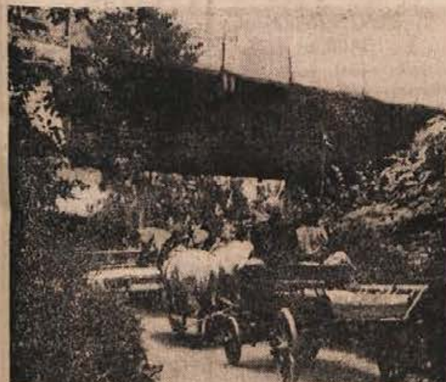
V sevniški občini je toliko železniških prelazov kot v malokateri drugi. Ker zahteva njihovo vzdrževanje precej stroškov, nameravajo ukiniti vse tiste, ki niso nujno potrebni. Na sliki je podvoz v Sevnici. (Foto: ...)
