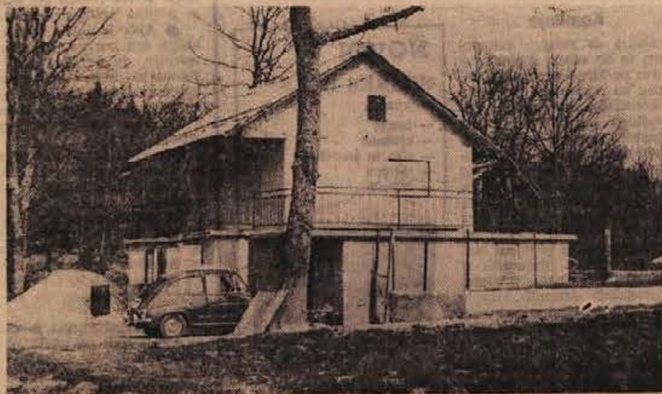
ČE NE MOREJO RASTI STANOVANJA — PA NAJ RASTEJO VIKENDI? Tako se upravičeno sprašuje delavec, čigar hiša je med prvimi na vrsti za rušenje. Še bolj smo lahko ogorčeni, če rastejo ČRNI vikendi ob Krki pri Dragi, v Dolenjskih Toplicah, na Trški gori, v Bučni vasi (na sliki) in drugje. Nekaj jih je v postopku — kaj pa drugi?
