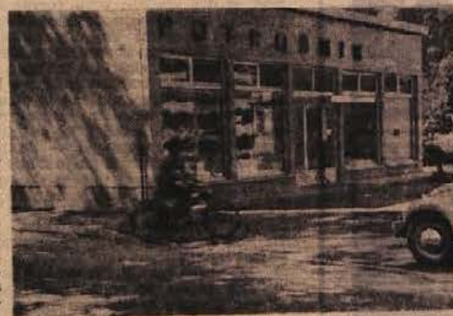
Preureditev trgovine Potrošnik na Reški cesti v Kočevju je Trgopromet vezjala okrog 42 milijonov starih din. V starih prostorih so uredili skladišče, v novem prizidku pa je sodoben prodajni prostor. Trgovina je v tem delu mesta nujno potrebna. (Foto: F. Grivec)
