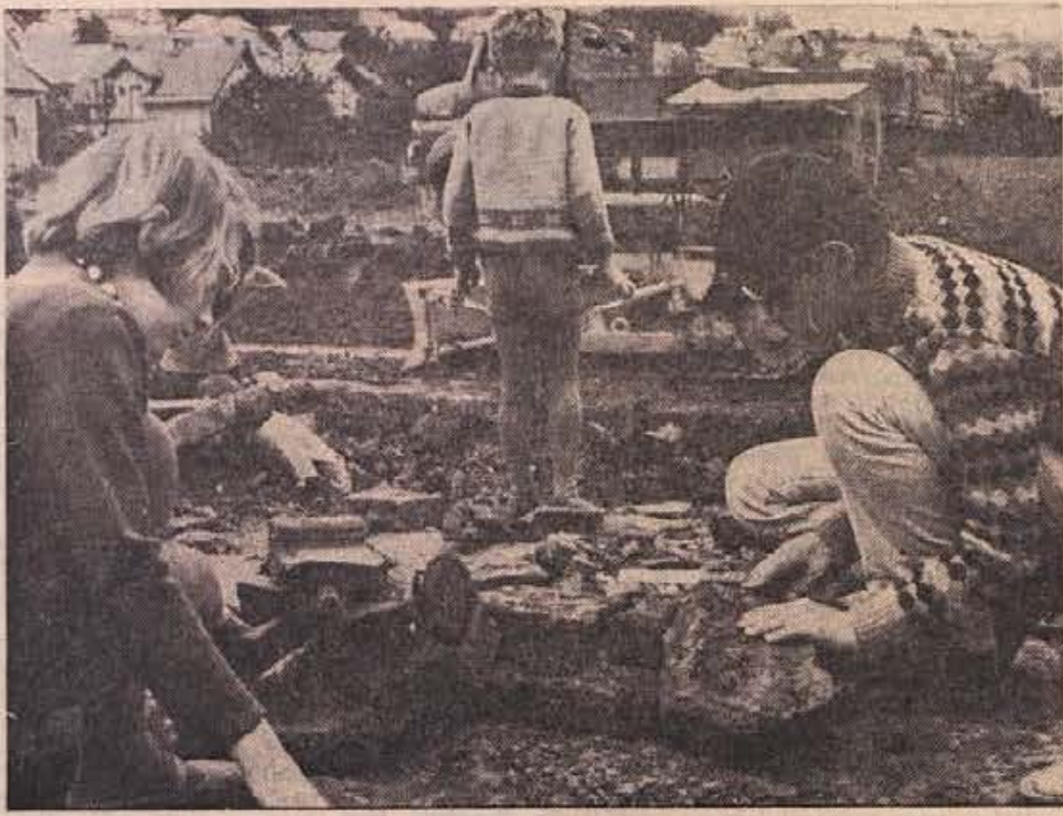
Prejšnji teden so pri kopanju gradbene jame za nov stanovanjski blok v Sevnici odkrili ostanek naselbine iz drugega stoletja našega štetja. To je na podlagi opeke in na njej vrčanih risb v petek popoldne, 14. junija, ugotovil dr. Komelj iz Zavoda za spomeniško varstvo. Najdba je med ljudmi zbudila veliko zanimanja, na najdbišče sta prišla tudi predsednik in podpredsednik občinske skupščine. Kopanje jame so začasno ustavili. O najdbi bomo še poročali. (Foto: M. Legan)
