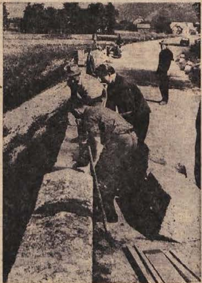
ZA KAKO DOLGO? Težka kamnita ograja na ozkem boštanjem mostu čez Mirno, kjer se je letos zgodilo že več hudih nesreč, je znova popravljena. Vprašanje je, kako dolgo bo držala ta začasna rešitev. (Foto: Legan)
