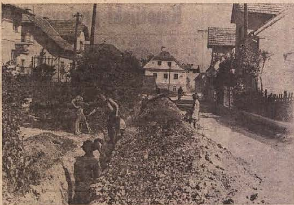
Gradnja vodovoda v Sentiernju razmeroma hitro napreduje. Jarek za glavni vod je izkopen že do središča Sentiernja. Z bagrom napravijo jarek, prebivalci ga poglobijo še z lopatami (Foto: Polde Miklič)
