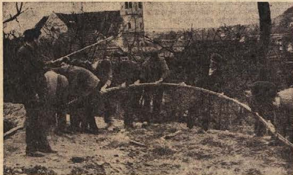
Električni in telefonski vodi so v mestih že prava nadlega, ker je vzdrževanje drago, pozimi, ko žice pokajo, pa so nevarni. Da bi se izognili takšnim nevšečnostim, uvajajo tudi v Krškem vedno več zemeljskih kablov. Na sliki: pri polaganju visokonapetostnega zemeljskega kabla na Polšci se sporazumevajo delavci med seboj po radijski zvezd (Foto: Tone Zalokar, Krško — druga nagrada za fotografijo tedna)
