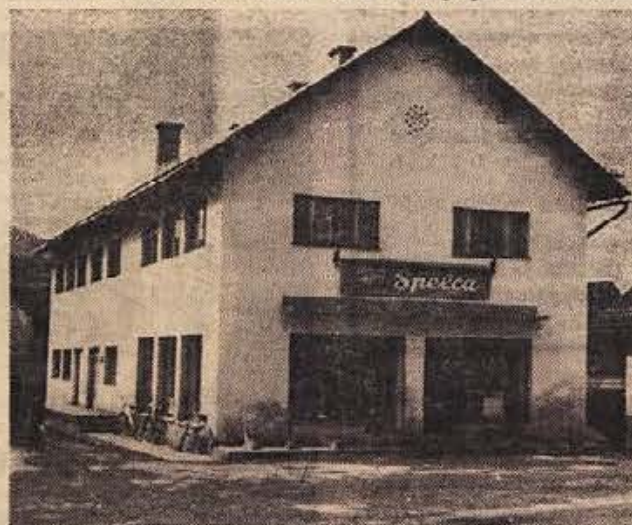
V tej zgradbi ni le dobrepoljska trgovina »Spelca«, ampak tudi upravni prostori kmetijske zadruga (Foto: Prime)
