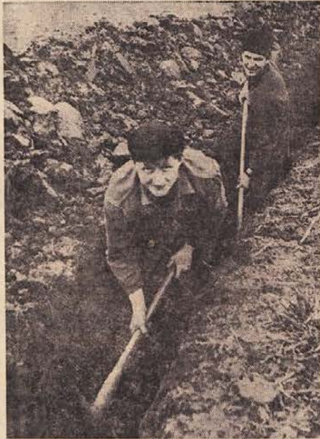
V Bistrici pri Mokronogu so začeli kopati jarke za priključke na glavni vod. (Foto: Legan)
