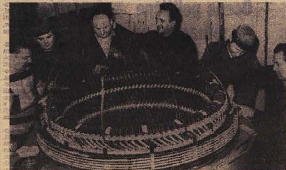
HITRI IN UCINKOVITI POSEG strokovne ekipe na naši sliki v drobovje glavnega stroja krške CELULOZE je rešil tovarno velike izgube. Jugoslovansko podjetje, ki je stroj izdelalo, ni moglo zagotoviti popravila prej ko v dveh mesecih, krški strokovnjaki pa so s pomočjo dveh Siemensovih ljudi spravili stroj v tek po sedmih dneh. — (Foto: Tone Zalokar, Krško — druga nagrada za fotografijo tedna)
