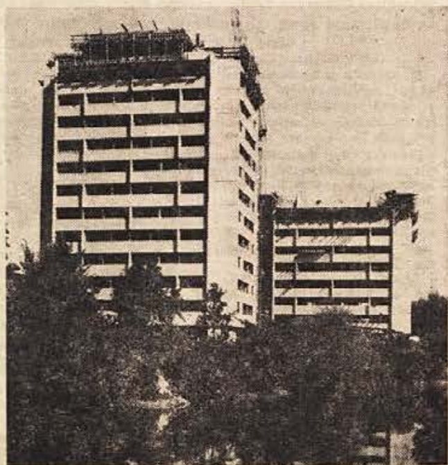
Na Zaloški cesti v Ljubljani gradi »Zidar« dve stolpnici
