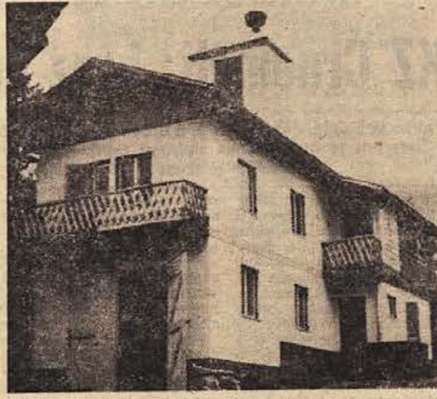
V nove prostore se je te dni preselila uprava obrata INLES »Smreka« v Loškem potoku. Gradnja upravne stavbe, v kateri je tudi gasilski dom tega obrata, je veljala 12 milijonov starih dinarjev. Stavbo je v približno letu dni zgradila gradbena skupnost INLES. (Foto: Vesel)
