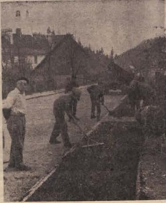
2200 kvadratnih metrov pločnikov so asfaltirali v Sodražici od 7. do 11. novembra. Dela je izvajala posebna ekipa podjetja »Slovenija ceste«, investiralo pa jih je stanovanjsko komunalno podjetje Ribnica. (Foto: Primc)
