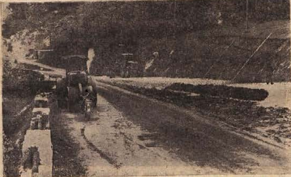
Nevarni plaz pri Dolenjskih Toplicah, na račun katerega smo se večkrat jezili, bo končno odstranjen. Pri Cestnem podjetju v Novem mestu, ki izvaja dela, smo izvedeli, da bo cesta v kratkem nared, če bo kolikor toliko ugodno vreme. (Foto: S. Dokl)
