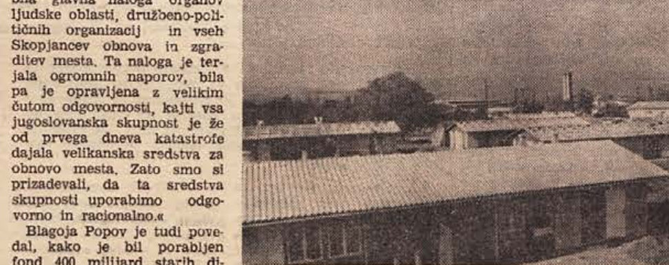
Naselje »Jelovica« je zrastle s pomočjo Slovenije kmalu po izgradenju
