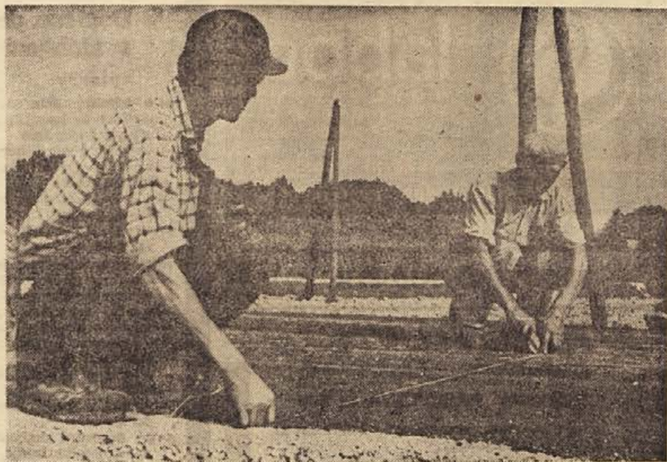
Dobro uro pred otvoritvijo ceste Bizeljsko—Zupelevec sta delavca cestnega podjetja še zadnjikrat premerila širino asfaltiranega cestišča na križišču pri Zupelevcu. Po končanem delu so se delavci zbrali v Stari vasi, kjer so jim ljudje pridelili skromno pogostitev. (Foto: J. Teppey)
