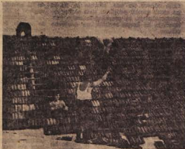
Taka je bila streha tovarne BETI, ko so nanjo splezali prvi delavci, komaj četrt ure potem, ko jo je toča zrešetala.
