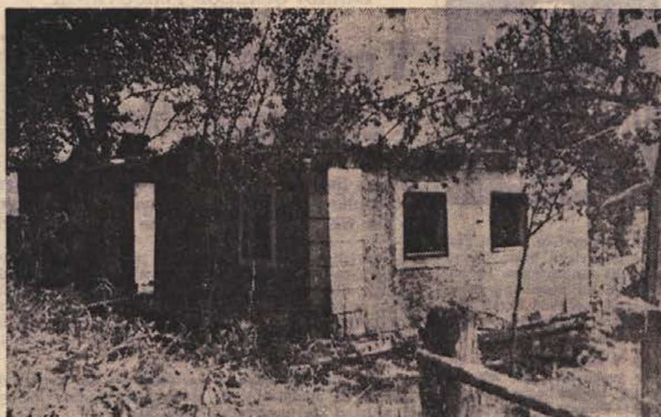
V noči od nedelje na ponedeljek, 19. junija, je nenadoma nastal požar v opuščeni stanovanjski hiši na Lokvici 43. Lastnica Marija Bele živi v Franciji in hiše ni imela zavarovane. Požar je poslopje, krito s slamnato streho, popolnoma uničil, čeprav so vaški gasilci požrtvovalno posredovali (Foto: Ria Bačer)
