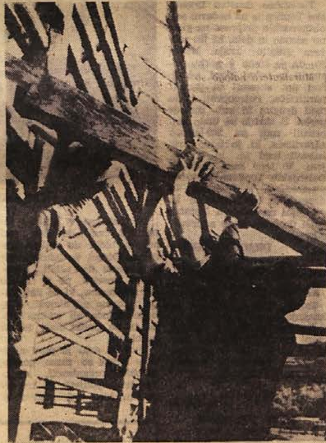
»Deteljo bo zdaj zdaj treba kositi, žito je že v klasju, pri popravilu kozolcev pa smo med zadnjimi,« so povedali možje v soboto, 20. maja, v Artmanji vasi pri Dobrnicu, ko so popravljali Lisjakov kozolec. Večina kozolcev je resda že obnovljenih in sledov strašne lanske noči, ko je neurje podrlo čez 40 kozolcev, kmalu ne bo več. (Foto: M. Legan)
