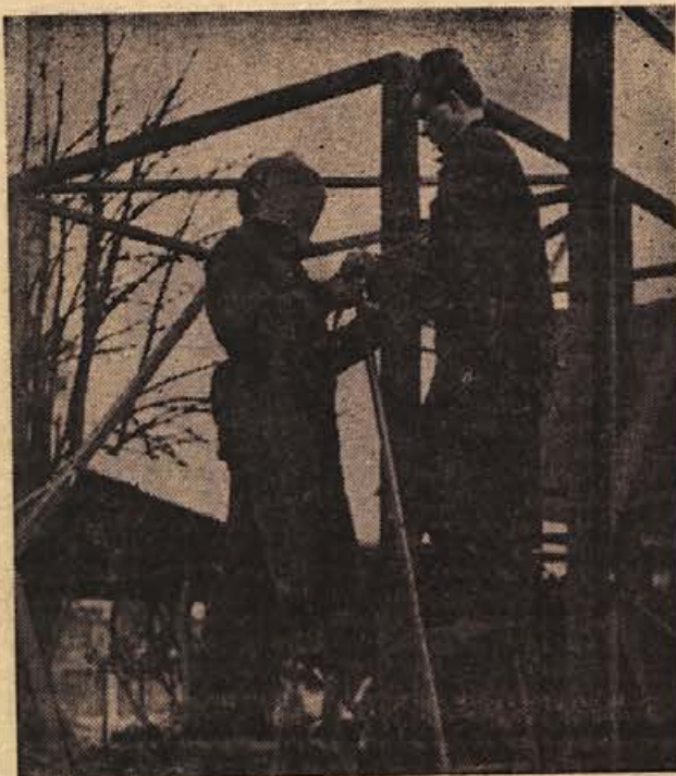
Obrtno kovinsko podjetje v Dobovi prevzema naročila za ogromne kovinske konstrukcije iz vse države. Na sliki: Franc Kežman in Edvard Pungartnik pri varjenju ogrodja za sušilnico, ki ga izdelujejo za Strojno kovinsko industrijsko podjetje SKIP iz Ljubljane.
