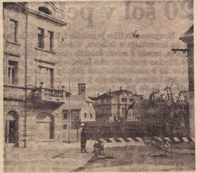
Most proti Rudniku bo zaprt približno 14 dni, ker polagajo na Roški cesti v Kočevju čez cesto cevi za novo kanalizacijo, ki bo odvajala odplake z levega brega Rinže za zapornice (Foto: Primc)
