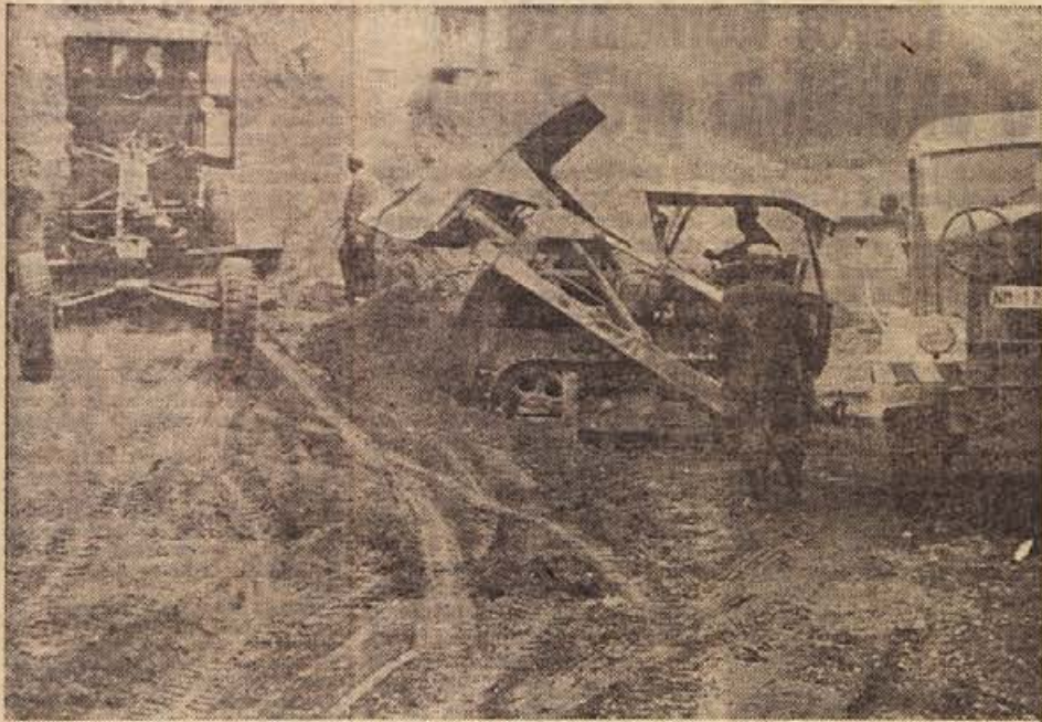
Pred železniško postajo v Brestanici asfaltirajo cesto. (Foto: J. Teppy)
