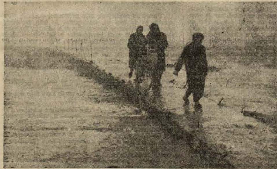
Mirenčani so v soboto dopoldne že lahko hodili po betonskem prehodu pri DANI, ki ga je ponoči prekrila razdivjana voda. (Foto: M. Legan)
