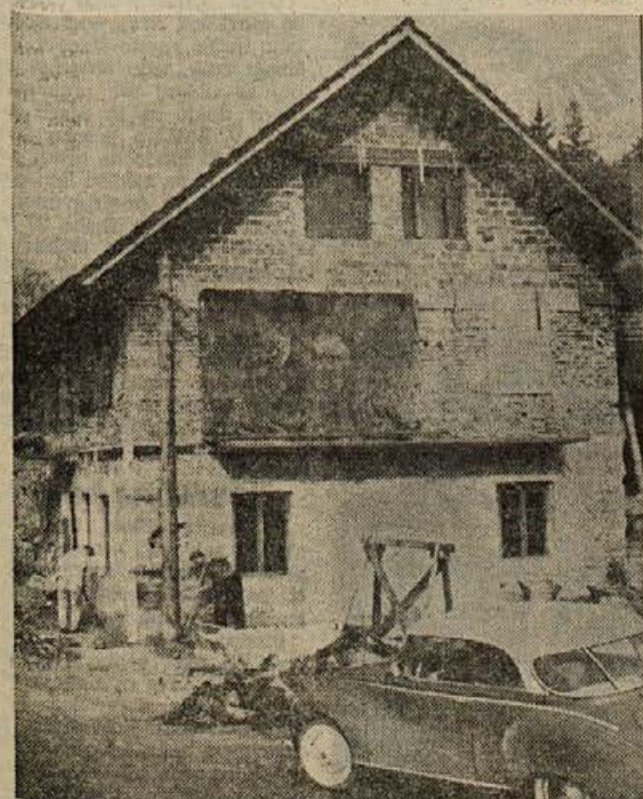
Kaprolovo gostilno v Sodražici obnavljajo. Praviijo, da bo urejena v prijetnem domačem slogu in opremljena z nekaterimi za turiste privlačnimi posebnostmi. Pri gostilni bodo uredili tudi več prenočišč. Kdaj bodo gostilno spet odprli, se še ne ve, prav gotovo pa bo začela spet posloovati do nove turistične sezone. (Foto: Prime)
