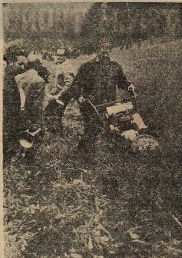
ROČNA KOSILNICA — Za košnjo v zelo strmih legah je v sosednji Avstriji zelo priljubljena 150 kg težka motorna kosilnica z oznako RN-LAHKA, moči 6 konjskih sil. Širina njene rezi je 140 cm, posebnost pa dodatna naprava z obračalnikom sena po imenu Hunnagd (senena dekla). Tam stane taka kosilnica približno 700.000 S din. (Foto: M. Legan)
