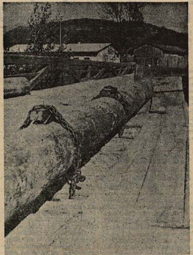
»S TRTO ZVEZAN, S KLINCEM ZBIT.« Betežni sevniški most čez Savo je prejšnji teden dobil še eno oporo. Debeli hlodi, ki ležijo na vozišču mostu, mu z verigami pomagajo, da se drži nad Savo (Foto: Legan)
