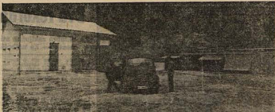
NOVA BAZA AMD. V nedeljo dopoldne so v dolinici nad železniško postajo v Novem mestu slovesno izročili namenu nove upravne prostore za delavnico in garažami novomeškega AMD. Gradnja novih prostorov je stala okoli 15 milijonov S-din, od tega so več kot 10 milijonov prispevali člani v denarju in s prostovoljnimi delom. Predsednik AMZ Slovenije inž. Vekoslav Jakopič je izročil ob otvoritvi novomeškemu društvu, še posebej pa dvema članoma, diplome za uspešno delo in garnituro orodja za delavnico. (Foto: M. Moškon)
