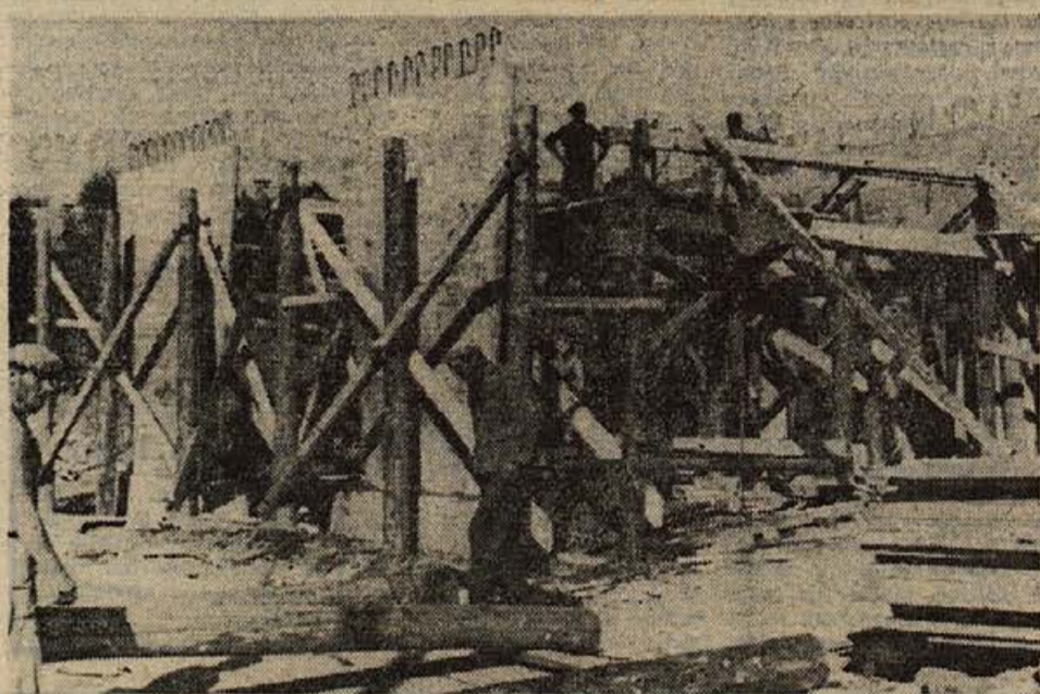
Stebri za most na Ulico 21. maja so že zabetonirani. Do 29. oktobra mora PIONIR napraviti še cestniše. Ob otvoritvi bo most prehodan le za pešce, vozila pa bodo smela čezenj mesec dni pozneje. (Foto: Baškovič, Brežice)
