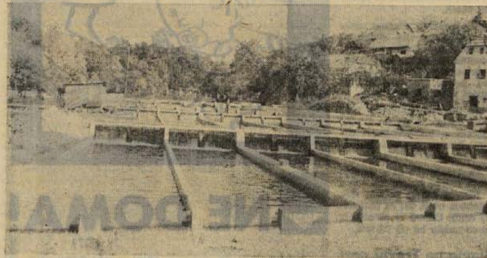
Takole se vrste stopničasti bazeni ribogojnice na Dvoru. Naravni padec vode skrbi, da so bazeni vedno dovolj polni sveže vode.
