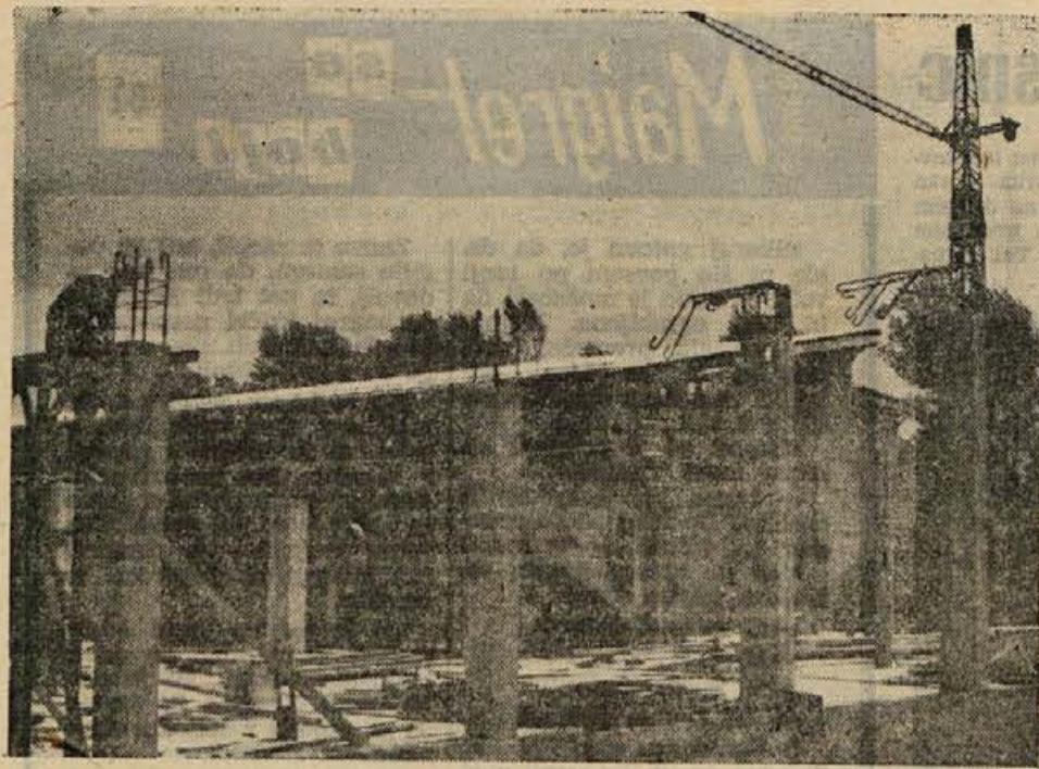
Trakt A (v ozadju) nove osemletke v Kočevju bo dograjen že do konca julija, pouk pa bo v njem že to jesen. Trakt B (stebri v ospredju) je šele v gradnji, dograjen pa bo do jeseni. (Foto: J. Primc)
