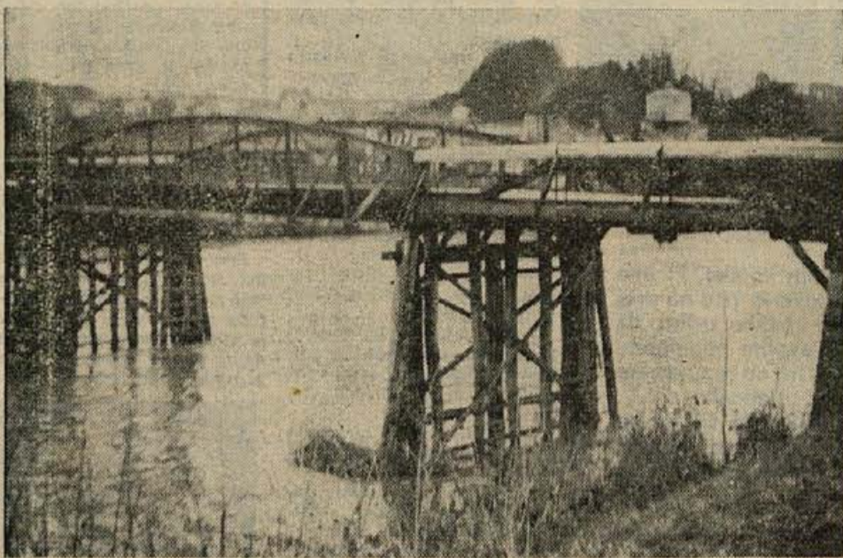
Zakrpani most čez Savo v Sevnici vzdrži komaj tri tone in težja vozila sploh ne morejo čezenj. Sevnica ima dobro povezavo le z železnico, medtem ko morajo tovar z večjih kamionov onstran mostu prekladati na manjša vozila! To povzroča velike dodatne stroške vsem delovnim organizacijam, ki so odvisne od dovoza in odvoza blaga (Foto: J. Teppy)
