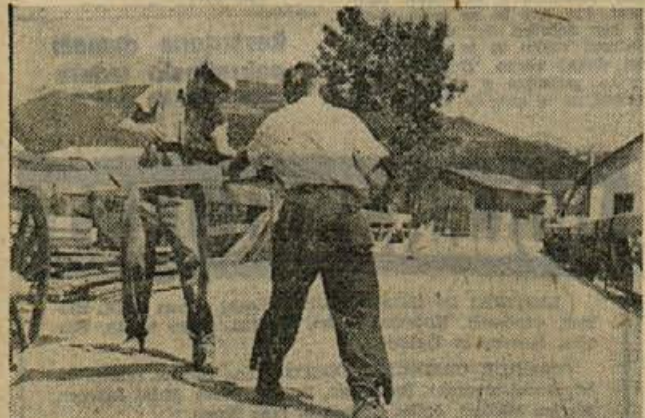
Na sevniškem mostu čez Savo te dni pridno zamenjujejo pod. Vseposod, kjer so deske že trhle, bodo položili nove, da bo promet spet varen.
