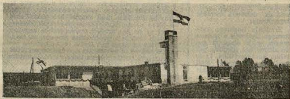
Pogled na novo stavbo MODNIH OBLACIL v Trebnjem na praznik dela
