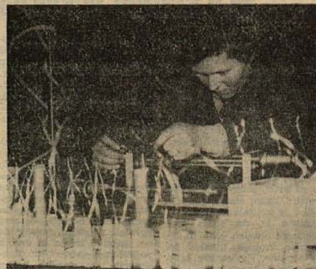
Ivanka Jenkole je v osmih letih navila že lepo število žarilnih tuljav za spajkala. Če jih navije vsak dan sto, račun ne bo težak...
