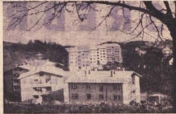
Novih 111 stanovanj — to je stanovanjsko naselje na Mestnih njivah. Nad »Kolonijo« ob Cankarjevi cesti v Novem mestu. Mestne njive so eno izmed večjih gradbišč SGP Pionir iz Novega mesta
