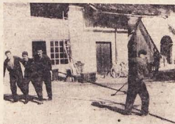
»To je pa uvožen stroj, tega morate slikati!« so se pošalili delavci Kovinoplasta iz Jesenic na Dol., ki so na dvorišču obrata s pomočjo preproste, na hitro narejene priprave okoli droga ovijali poldrugi centimeter debelo betonsko železo. Rade volje smo jim ustregli in se posrečenemu dovtipu nasmejali še mi...
