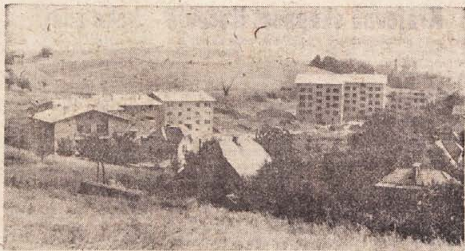
Novo stanovanjsko naselje na Mestnih njivah v Novem mestu dobiva že bolj zaokroženo podobo: 4 dograjenim blokom se pridružujejo trije novi, tu pa bo zrastle še več stolpnice
