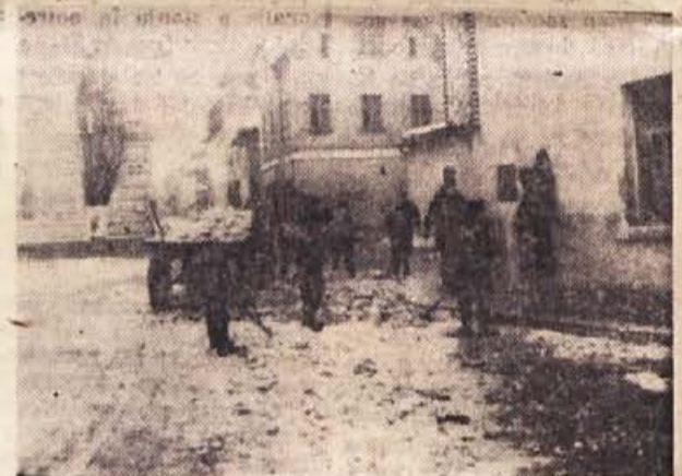
S čiščenjem ulic so se v Črnomlju malce zamudili, zato je zdaj delo težje. Pravijo, da je led trd kot beton. Prejšnji teden so delavci komunalne uprave čistili Trg svobode
