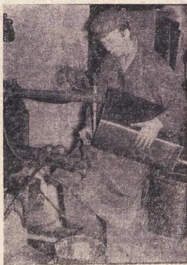
Tako nastaja v brežiškem obratu IMV bencinski rezervoar za priljubljeno vozilo »kombi«. Prizadevni kolektiv brežiškega obrata izdeluje kar 500 posameznih sestavnih delov za kombi
