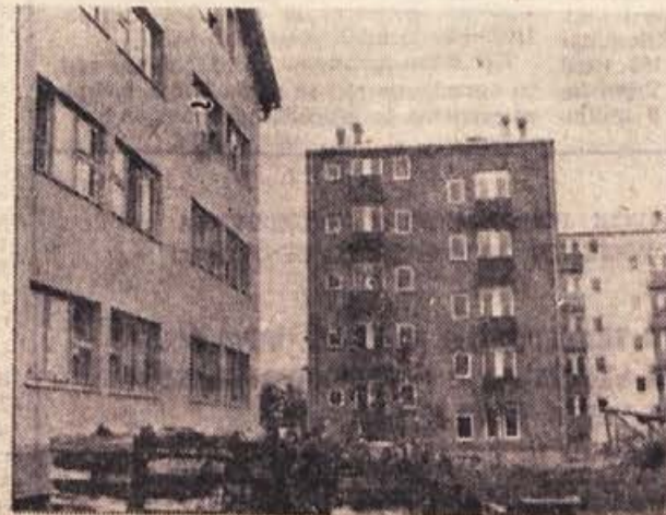
Dve takšni stavbi pomenita 30 in še več novih stanovanj ter pričata o skrbi za človeka in njegovo življenjsko raven
