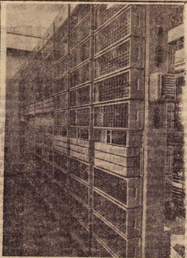
Del nove avtomatske telefonske centrale v Novem mestu — izdelala jo je industrija ISKRA iz Kranja
